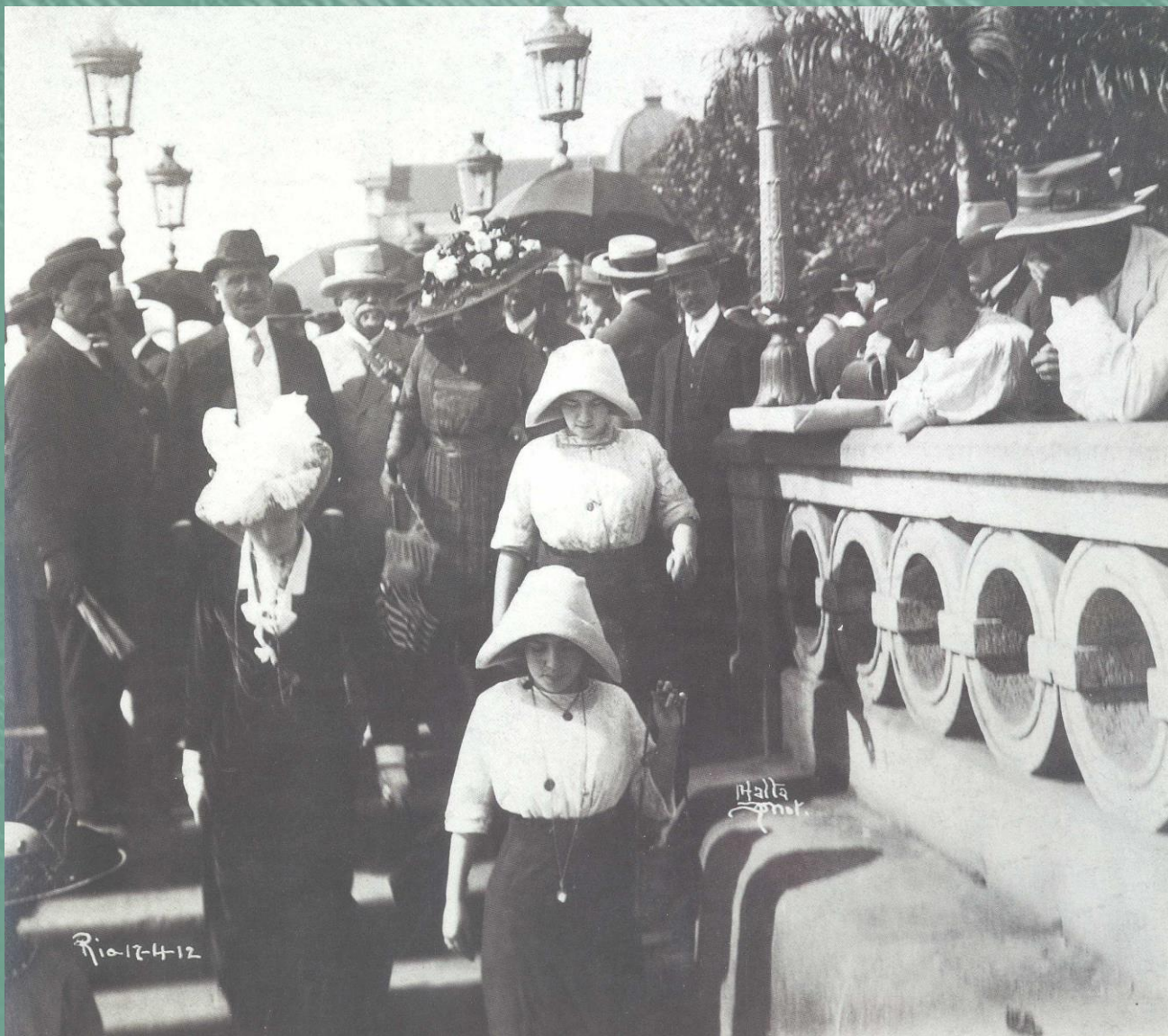
Canal do Mangue, inundação, 1912. Augusto Malta (1864 – 1957).
