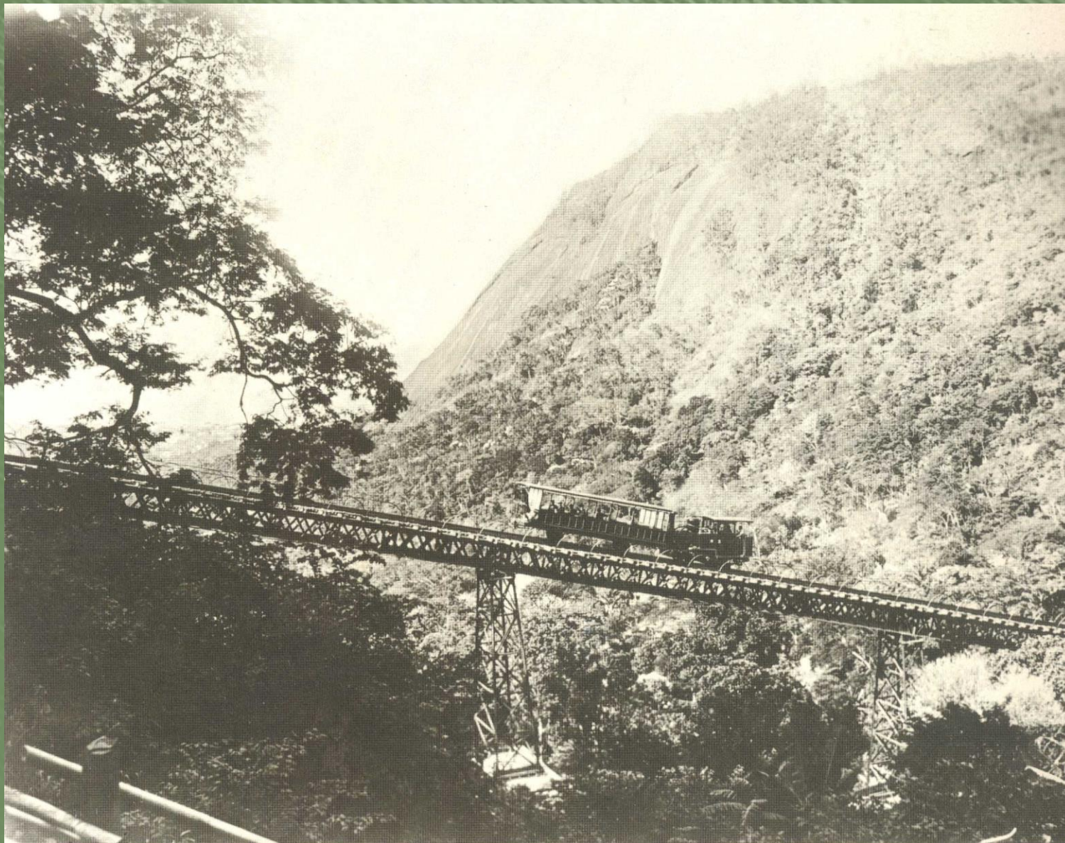
Viaduto do Silvestre (Corcovado), 1884.
