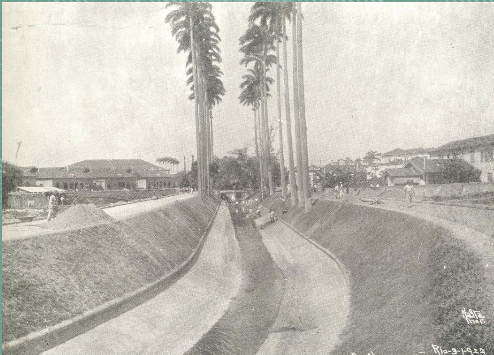
Avenida Maracanã (Trecho em construção - São Christovão), 1922. Augusto Malta (1864 – 1957).
